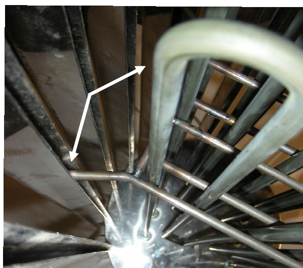
Immagine 4 Installazione del supporto per gli elementi riscaldanti
